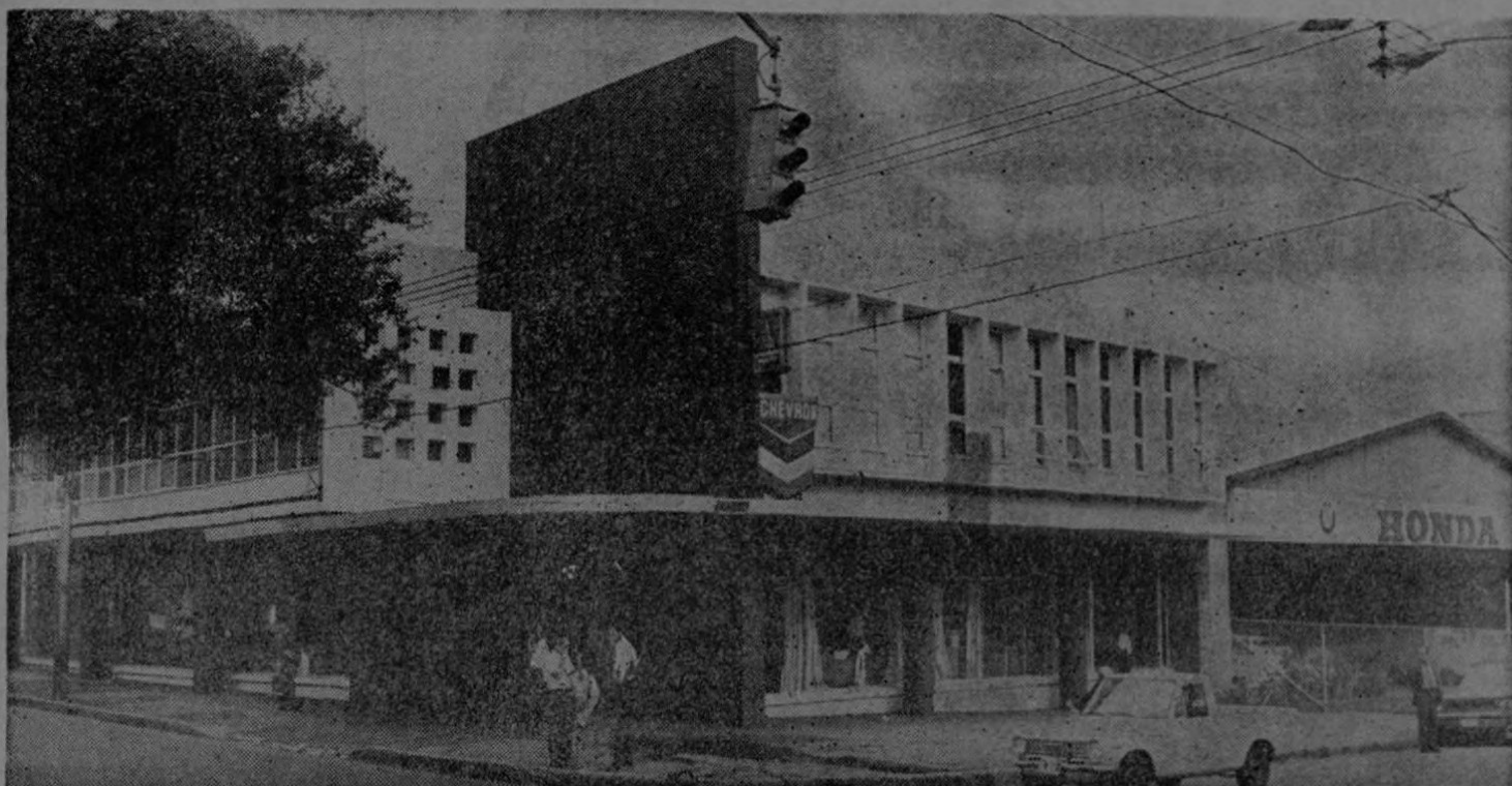
Fachada del edificio en donde están ubicadas las instalaciones FACO.
